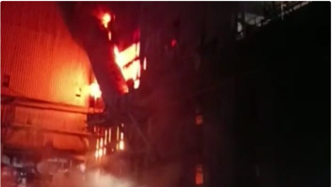
Tampak salah satu foto insident kebakaran yang terjadi di tungku PT GNI, Kamis dini hari (22/12/2022)
