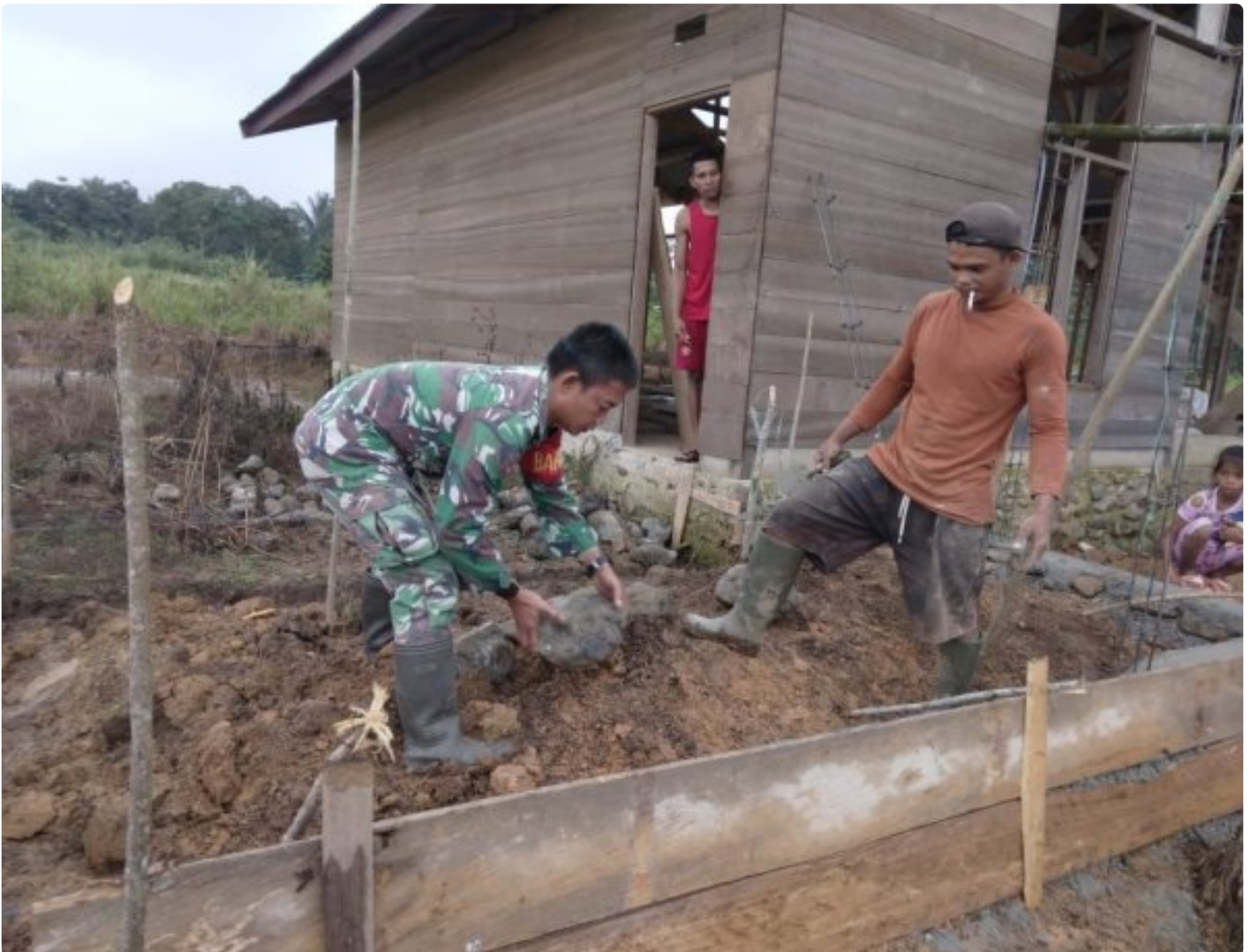
Serda Nonong bantu kerja pondasi rumah warga
